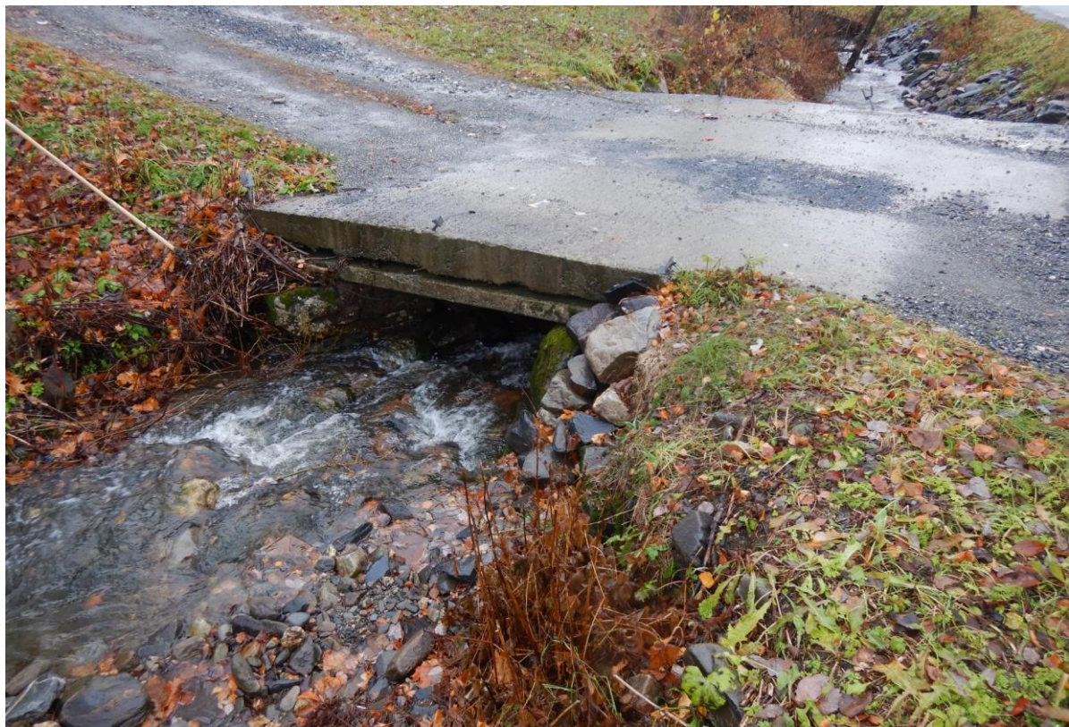
Bilde 4-20 Eksisterende kulvert ved pr. 1780
