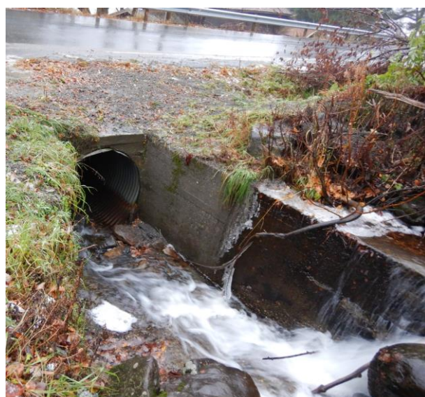
Bilde 4-8 Tatt ved innløp kulvert
