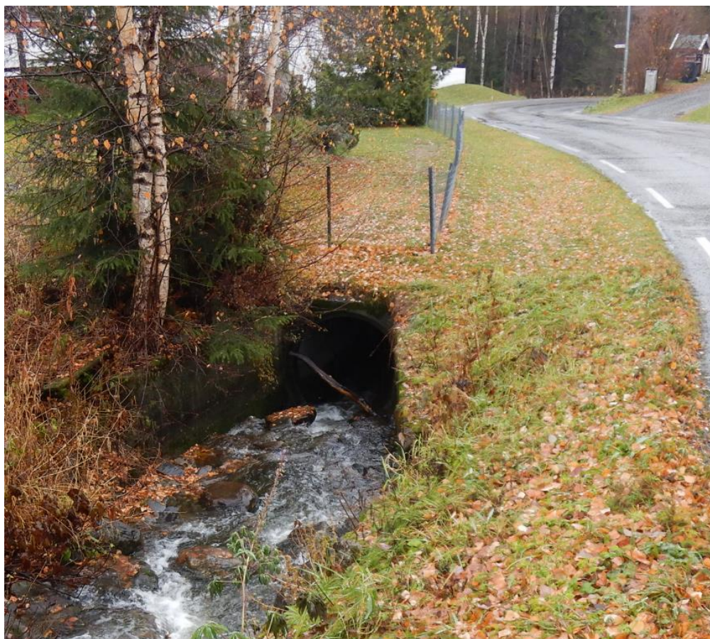
Bilde 4-22 Innløp eksisterende bekkelukking
