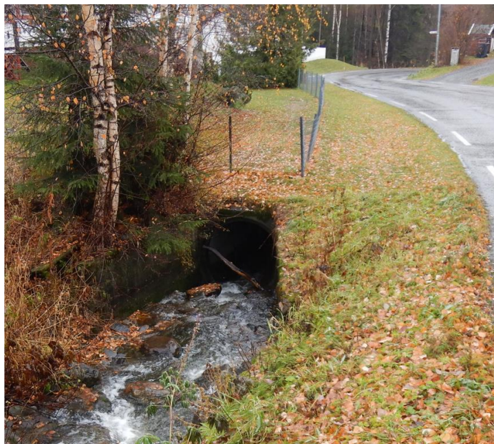
Figur 4.10: Innløp eksisterende bekkelukking
