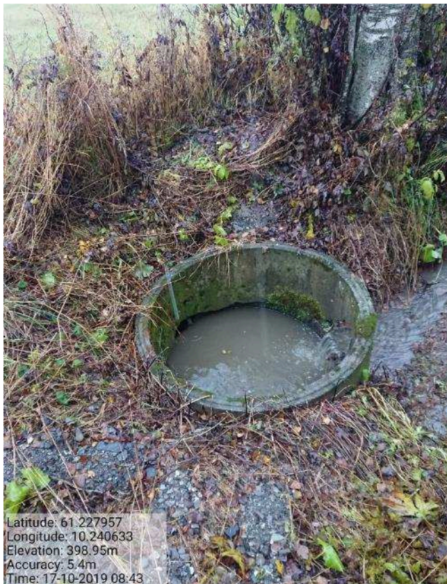
Bilde 33. Innløp for bekkelukking.
