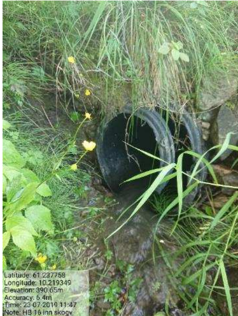
Bilde 23. Innløp landbruksveg.
