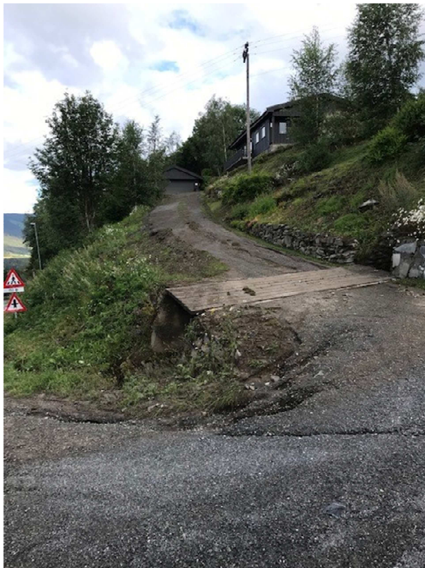
Bilde 13. Kulvert Kanadavegen 112 etter flomskredet sommeren 2019.
