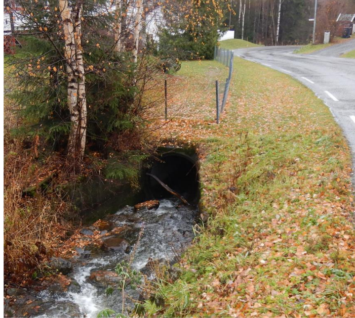
Figur 4.10: Innløp eksisterende bekkelukking
