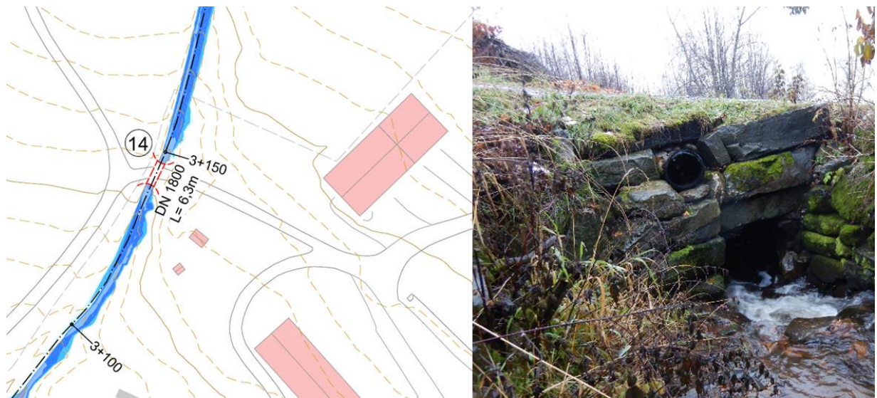
Figur 4.3: Tiltak ved Profil 3150
