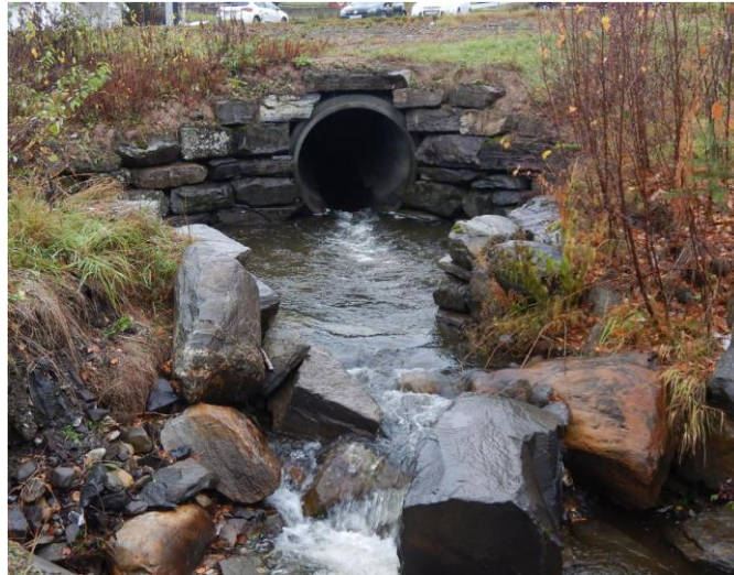
Figur 4.8: Utløp DN1600 gjennom Fv. 255
