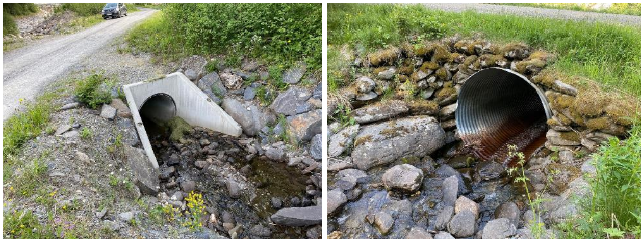
Figur 5. Venstre: inntak ved veikryssing km 0,035; høyre: Stikkrenne under veikryssing ved km 0,115.
