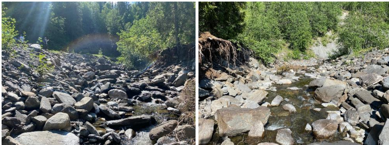
Figur 24. Venstre: km 0,15 langs Gryta sett motstrøms; høyre: km 0,15 sett medstrøms, viser rasutsatt område på nordsiden ved km 0,1.
