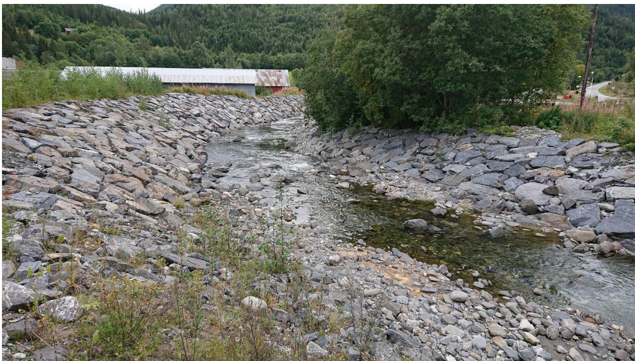
Figur 2. Den nedre delen av Dørja, ned mot utløpet til Jøra, er elva strengt forbygd med klassisk glatt plastring. Denne form for forbygning anses å være lite gunstig for vannmiljøet da vannhastigheten gjerne blir veldig høy i hele tverrsnittet.
