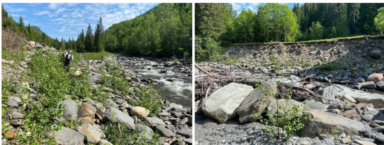
Figur 10. Venstre: km 1,1 sett motstrøms; høyre: km 1,35 langs yttersving
