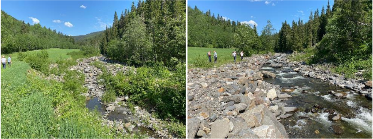
Figur 18. Venstre: km 2,25 langs vestre løp (hovedløp er lengst til høyre), sett motstrøms; høyre: km 2,45 sett motstrøms (naturresevatet er langs østre elvebredde) med erosjonssikring langs jordet på vestsiden.
