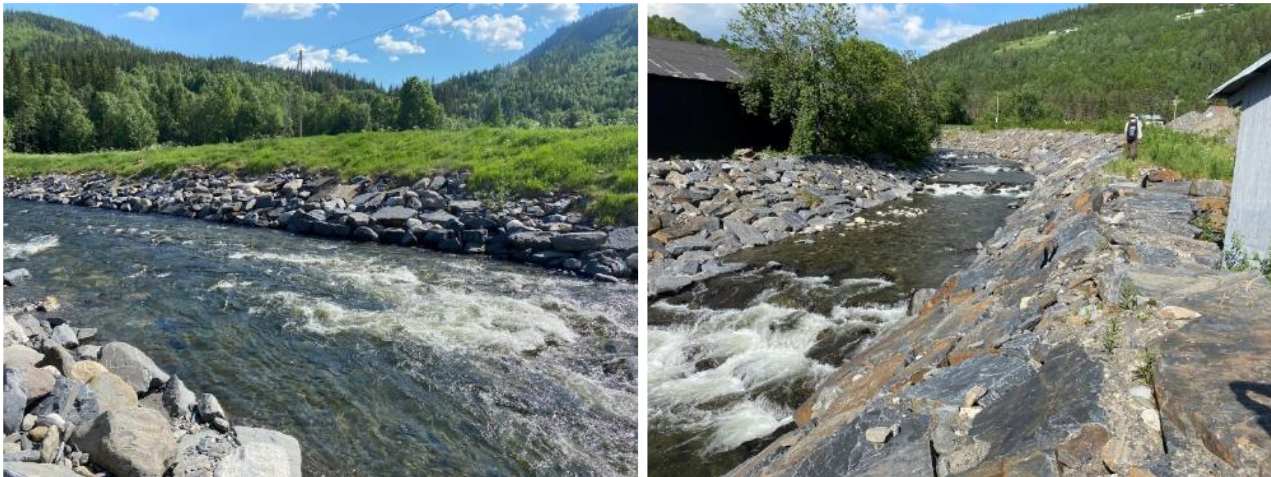
Figur 3. Venstre: Jøra like nedstrøms samløp; høyre: nedre del av Dørja ved Helleberg sag, kanalisert og erosjonssikret.
