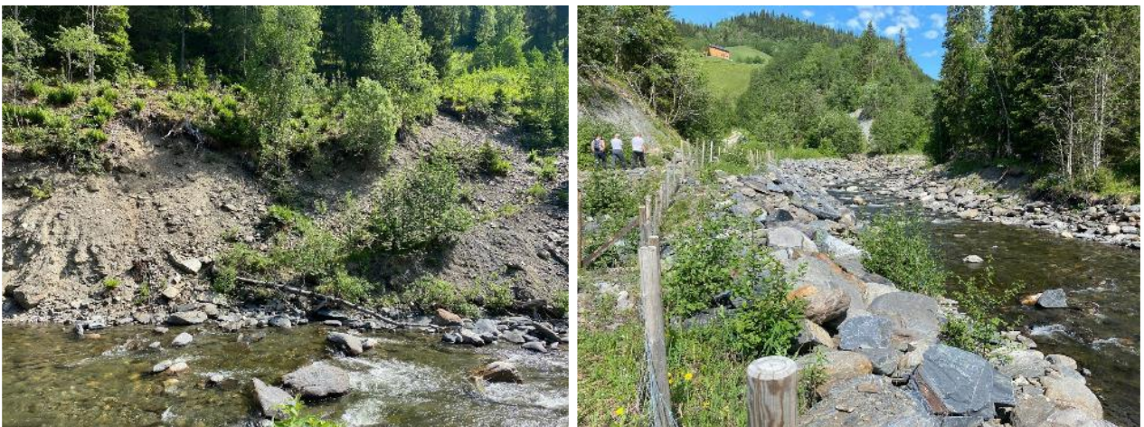
Figur 16. km 1,9 langs yttersving på østsiden av elva like nedstrøms starten på naturreservat; høyre: km 1,95 fra dette punkt og opp til samløp med Gryta er Dørja erosjonssikret i yttersvingen (vestsiden).
