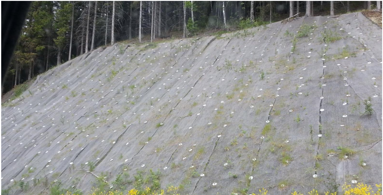
Figur 5-3. Erosjonssikring av skråning ved bruk av kokosnett i Fåvang, Ringebu kommune.
