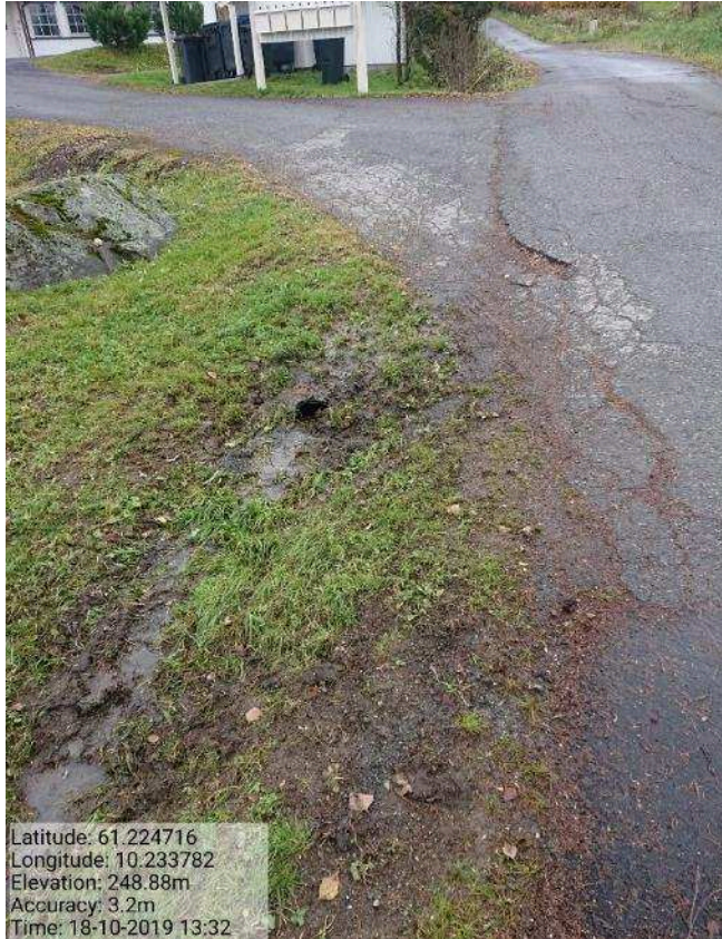
Bilde 153. Utløp under innkjøring Steinshågå 4.
