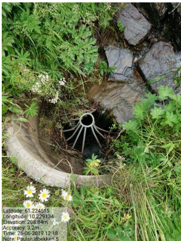
Bilde 114. Innløp, halvmånekum med rist Gausdalsvegen.
