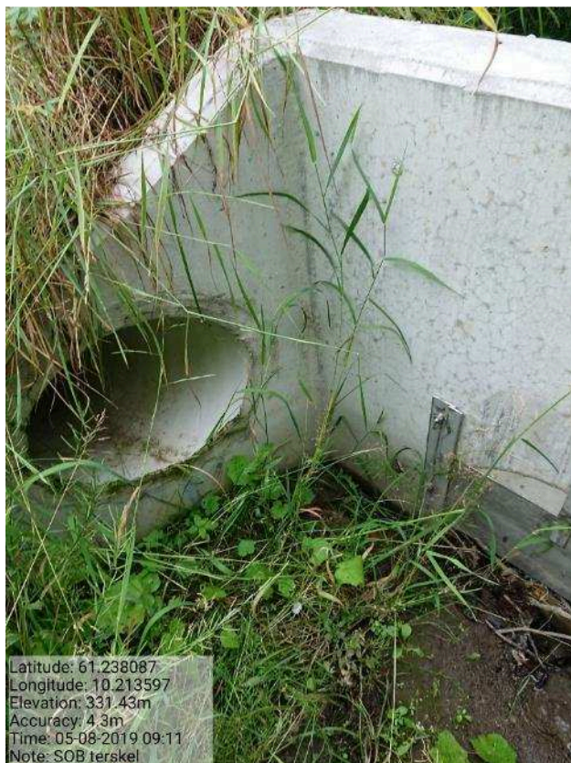
Bilde 27. Innløp landbruksveg.
