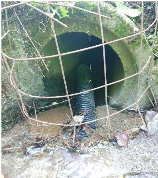
Bilde 148. Innløp Stensrudvegen.
