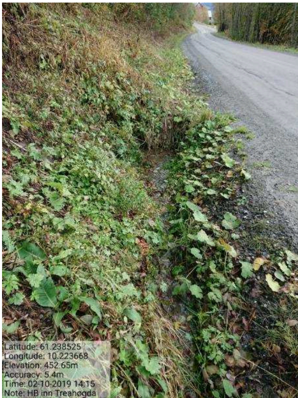
Bilde 75. Stikkrenne sør for Hagenbekken kryssing Treahøgda.
