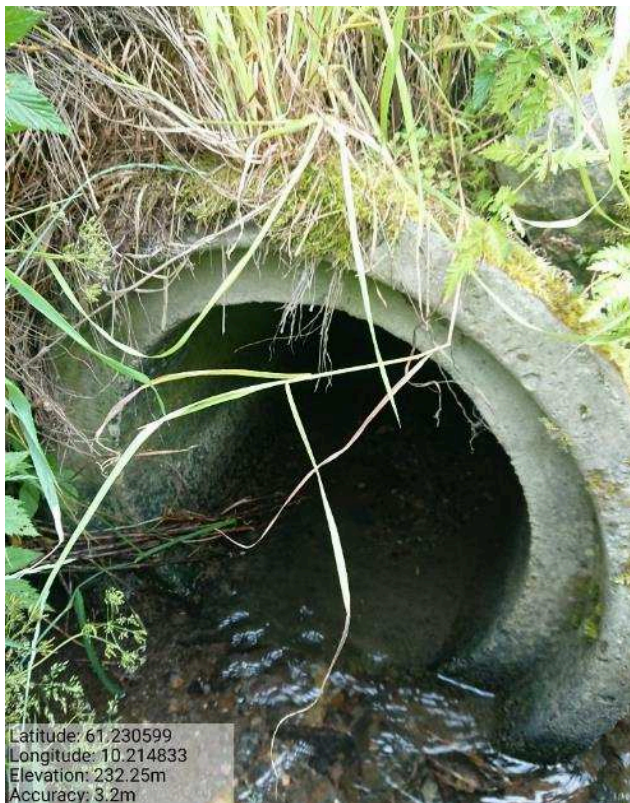
Bilde 41. Innløp landbruksveg.
