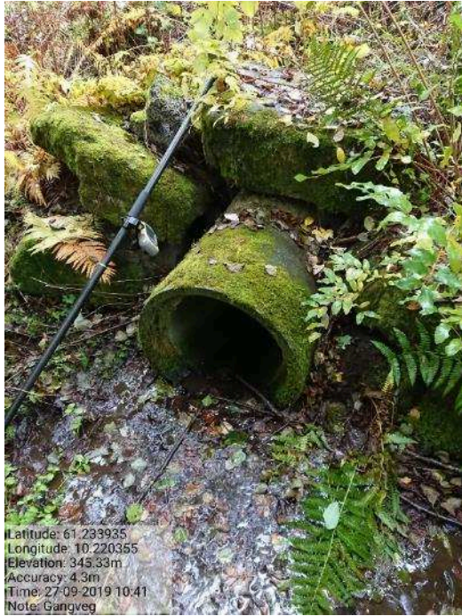
Bilde 87. Innløp gangveg nordre arm.
