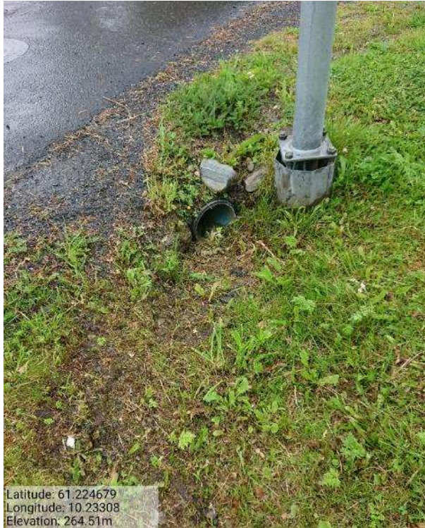
Bilde 151. Innløp Steinshågåen. Utløp i kum.
