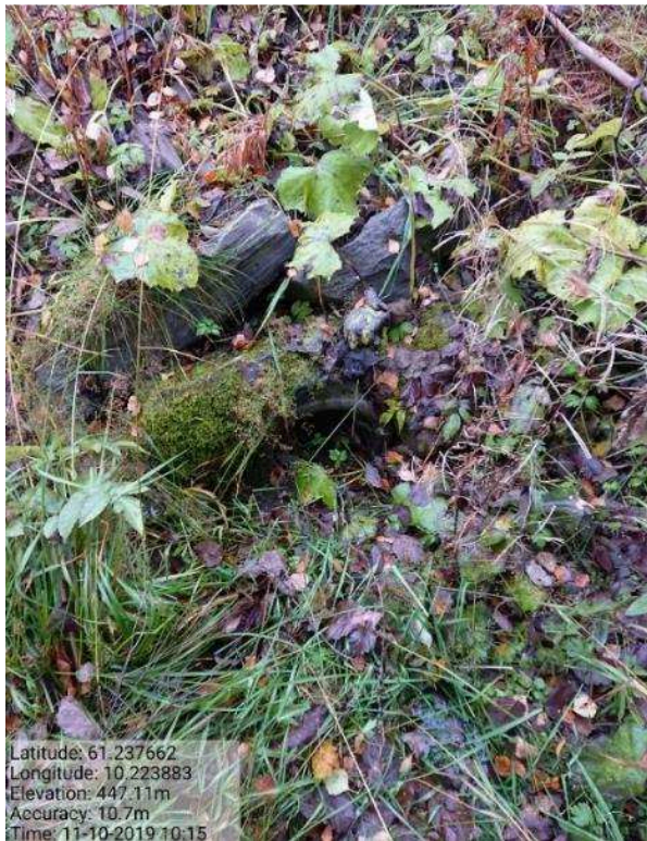
Bilde 76. Innløp landbruksveg.
