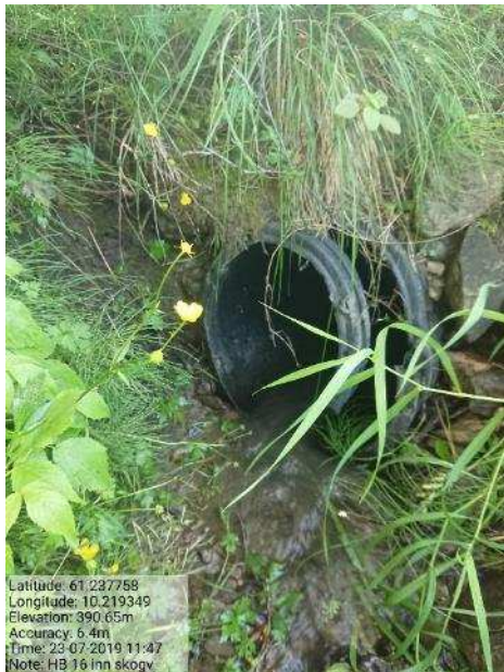
Bilde 63. Innløp landbruksveg.
