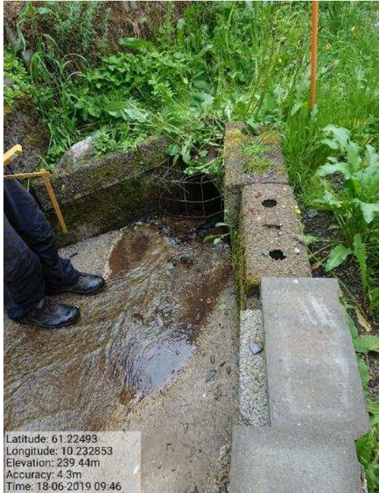
Bilde 147. Innløp Stensrudvegen.
