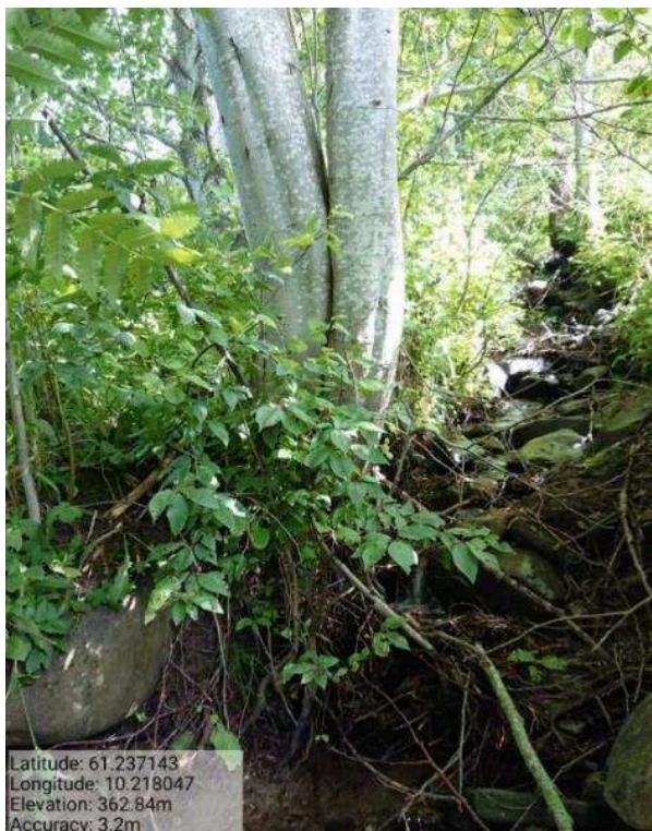
Bilde 62. Erosjonsskader truer med å felle trær ut i bekken.
