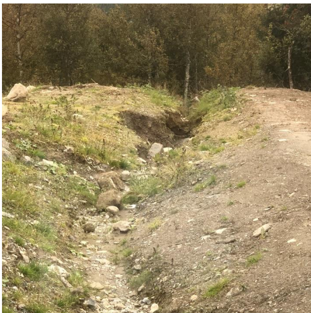
Bilde 35. Grøft mellom Toftlykkja 4 og 6.
