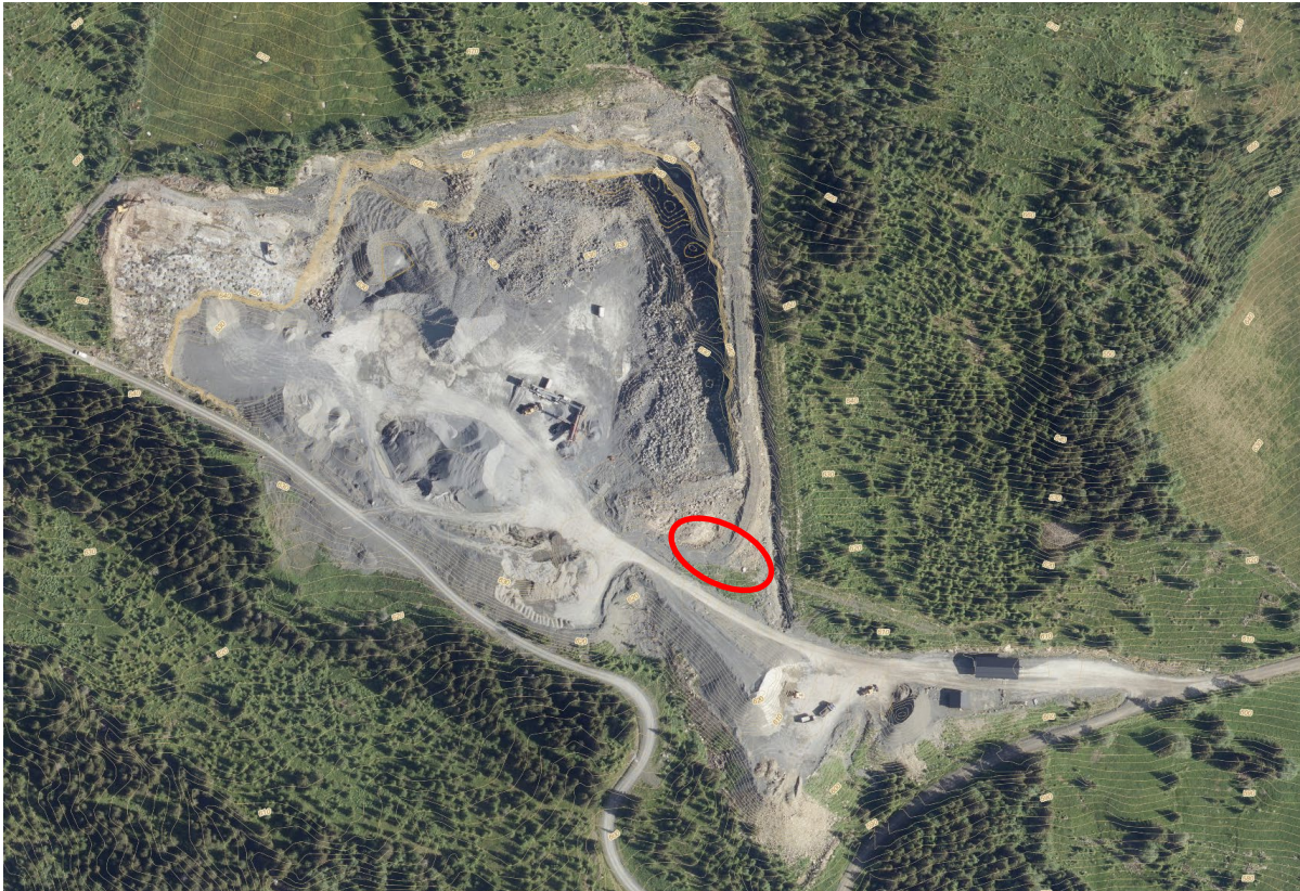
Figur 25 Utklipp fra Innlandsgis.no med markering av hvor det etableres sedimentasjons- og fordrøyningsbasseng
