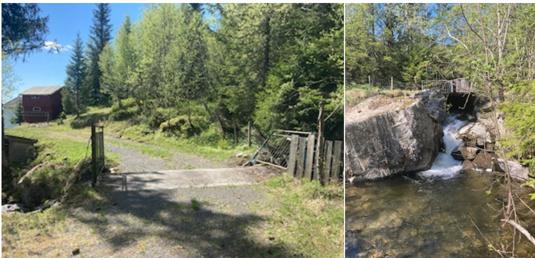
Figur 32 Bilder av nederste kulvert ved kulvert nummer 6.
