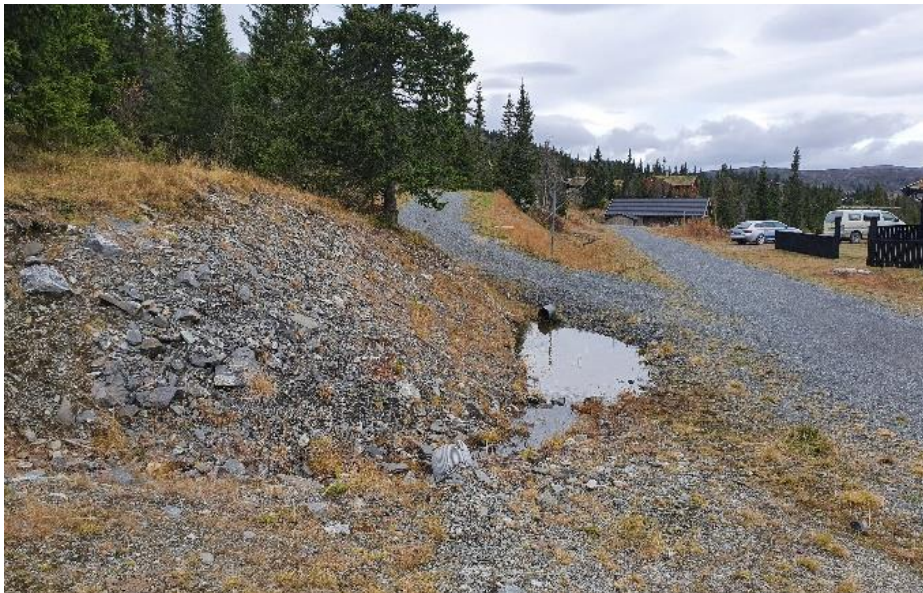
Figur 15: Innløpet til stikkrenne 21 oppstrøms Vestlia.
