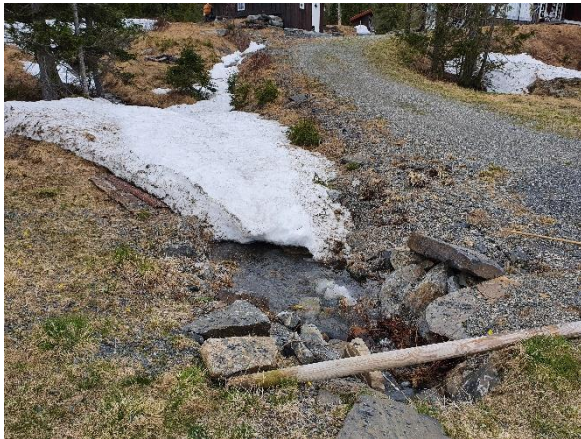
Figur 13: Foto av bekkeløpet inn mot stikkrenne 6.
