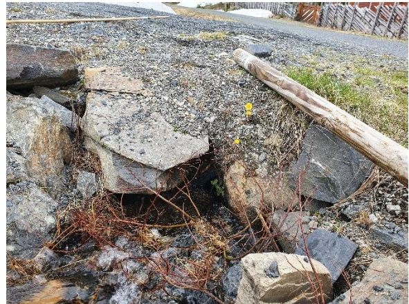
Figur 14: Foto av innløpet til stikkrenne 6.
