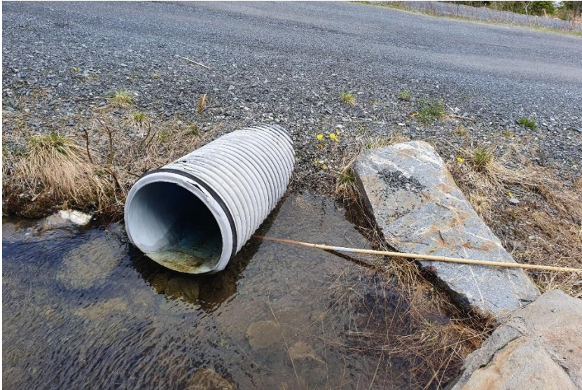
Figur 12: Foto av innløpet til stikkrenne 10, som stort sett ligger høyere enn grøfta.
