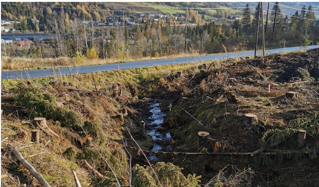
Figur 7: Bildet er tatt oppstrøms og mot innløpet av dagens stikkrenne gjennom Baklivegen.
