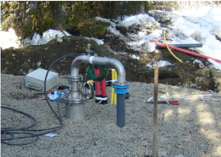
Figur 5-1 Etablering av en grunnvannsbrønn ved Forset i 2008
