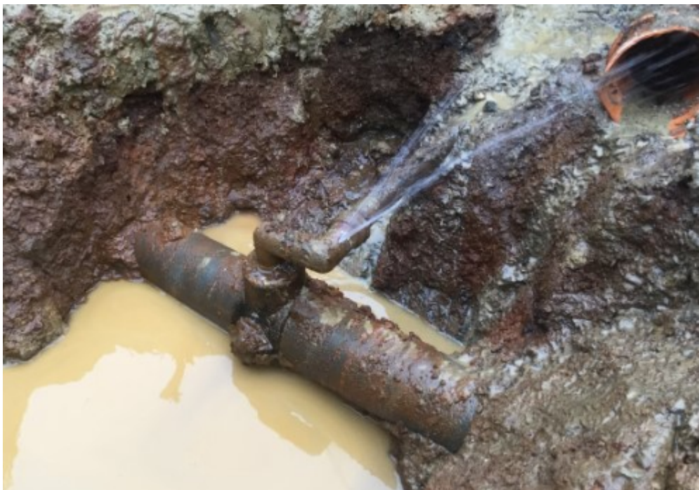
Figur 6-18 Bilde fra lekkasjesøking
