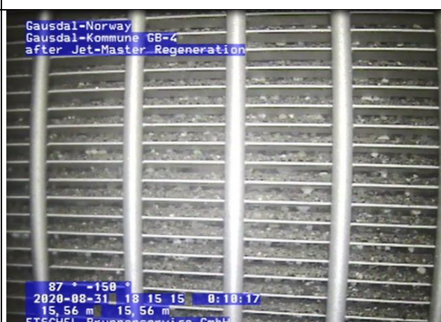
Figur 8. GB4 ved 15,6 m dybde, etter rehabilitering
