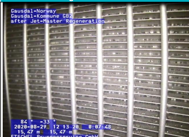
Figur 4. GB2 ved 15,5 m dybde, etter rehabilitering.
