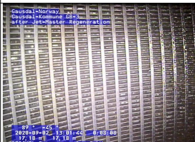
Figur 6. GB3 ved 17,2 m dybde, etter rehabilitering.
