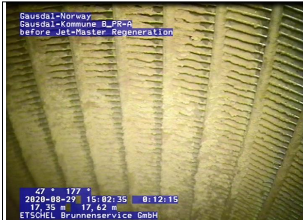
Figur 9. B_Pr-A ved 17,6 m dybde, før rehabilitering.
