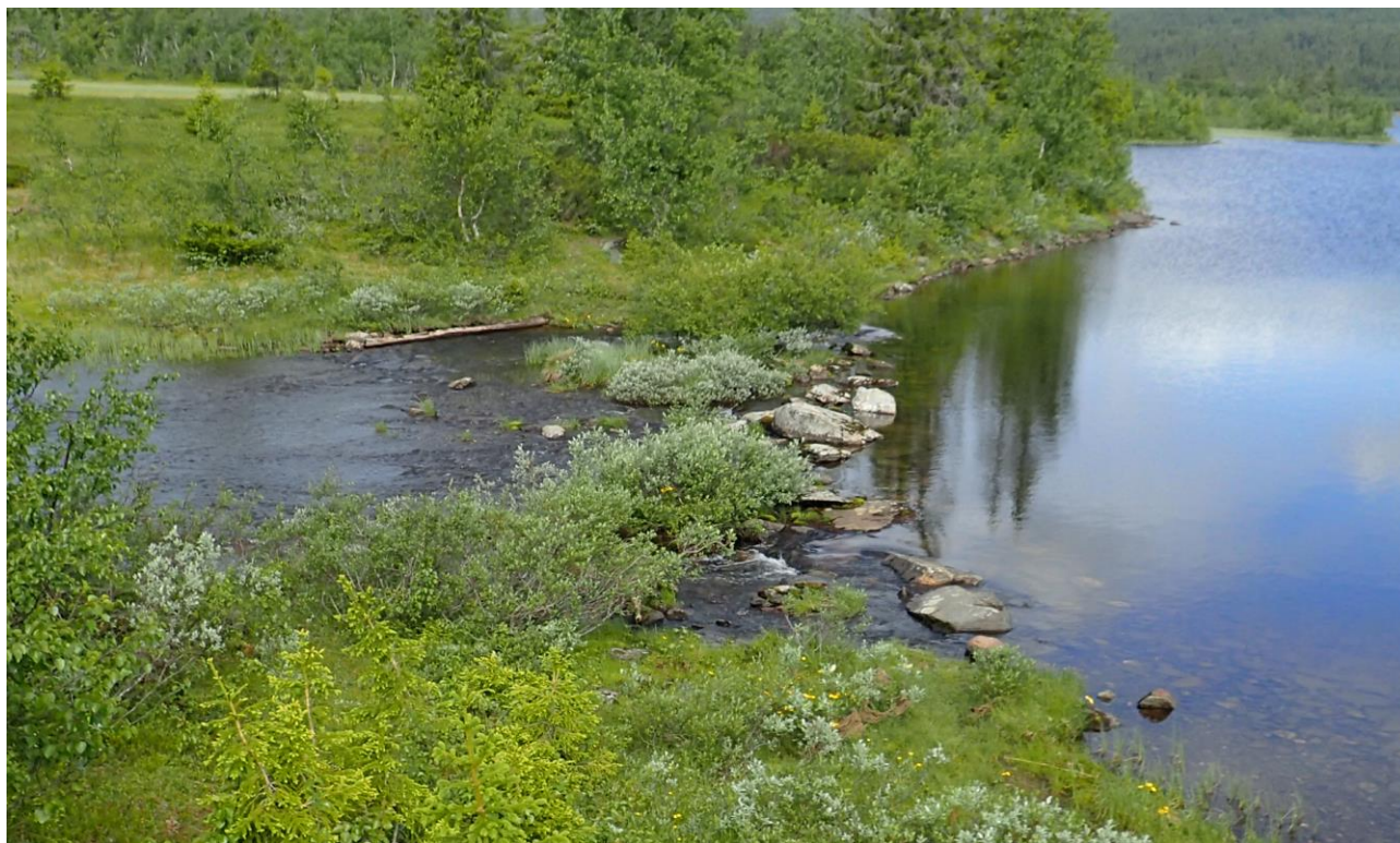
Figur 2-2 Stein / løsmasseterskelen ved utløpet av Sjøsetervatnet
