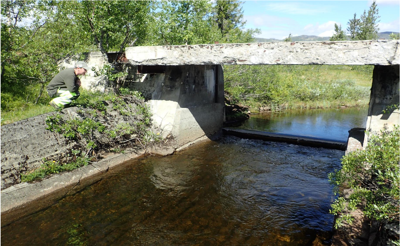
Figur 2-4 Gammel betongdam ca. 35 m nedstrøms terskelen (sett fra nedstrøms)
