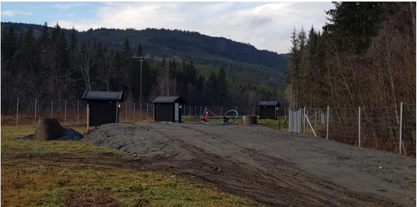
Figur 3-12 Brønnområde ved Hyttøya – eksisterende vannkilde Forset vannverk
